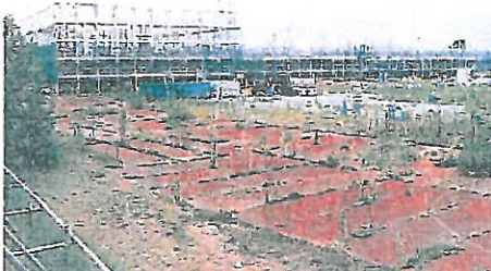
東京電力福島第一原発の事故以来、中断したままの楢葉中の工事現場
