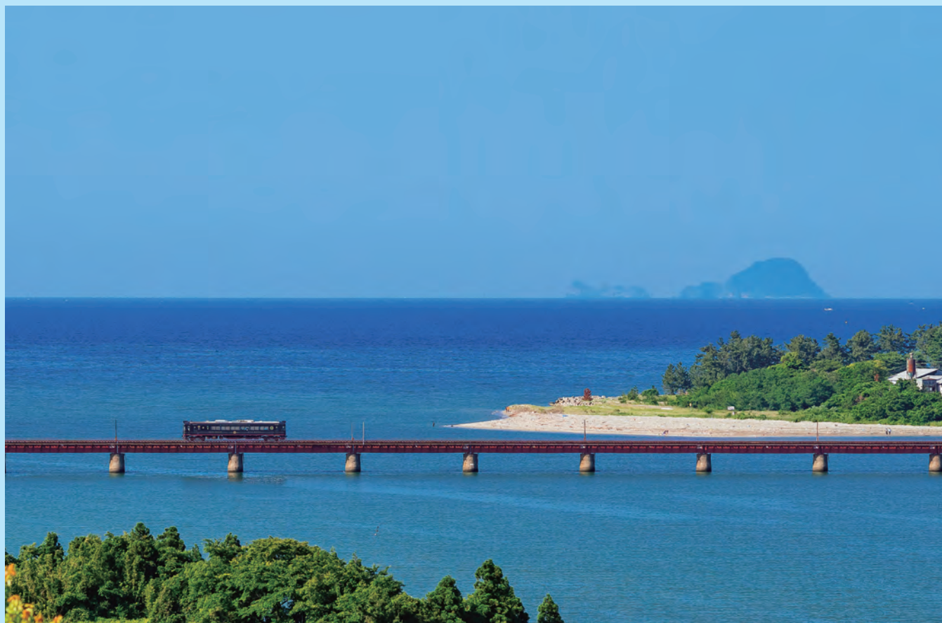
由良川橋りょう（京都府）
